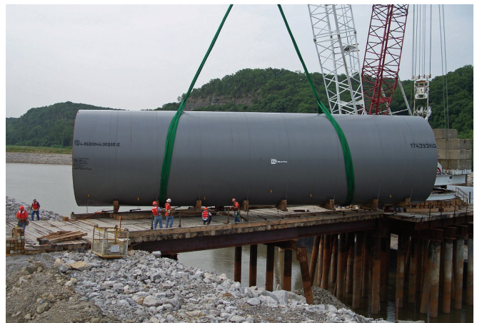
220 ton Cement Kiln
